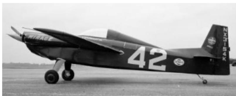
L'ensemble est rouge, avec lettres alu. La construction est facile, sans moulage. La seule difficulté me semble être un bon renfort de la nervure d'emplanture qui doit être soigné car le profil est mince. Pas de photo couleur, seulement un petit dessin en couverture d'American Modeler.
